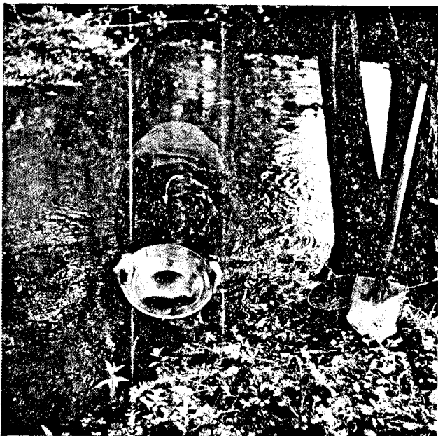
Fig. 4. -- Le retour aux anciennes techniques de prospection s'avère parfois nécessaire comme en Bretagne où l'étude méthodique des alluvions a permis au B.R.G.M. de découvrir d'importantes réserves de monazite à europium; ci-dessous, examen préliminaire à la batée.
